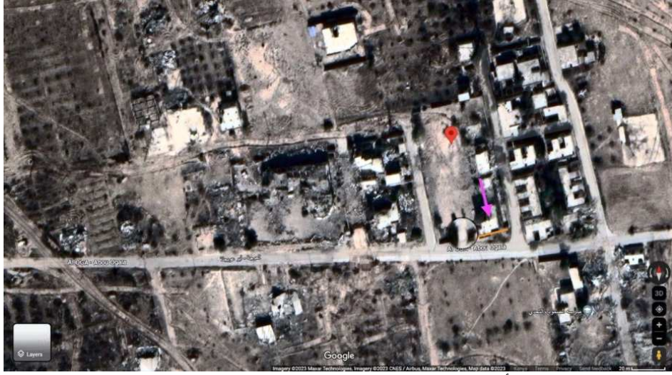
صورة 5: لقطة من الأقمار الصناعية تظهر المبنى المتهدم الفعلي والجدار الجنوبي ومبنى صغير على حافة المدرسة.
