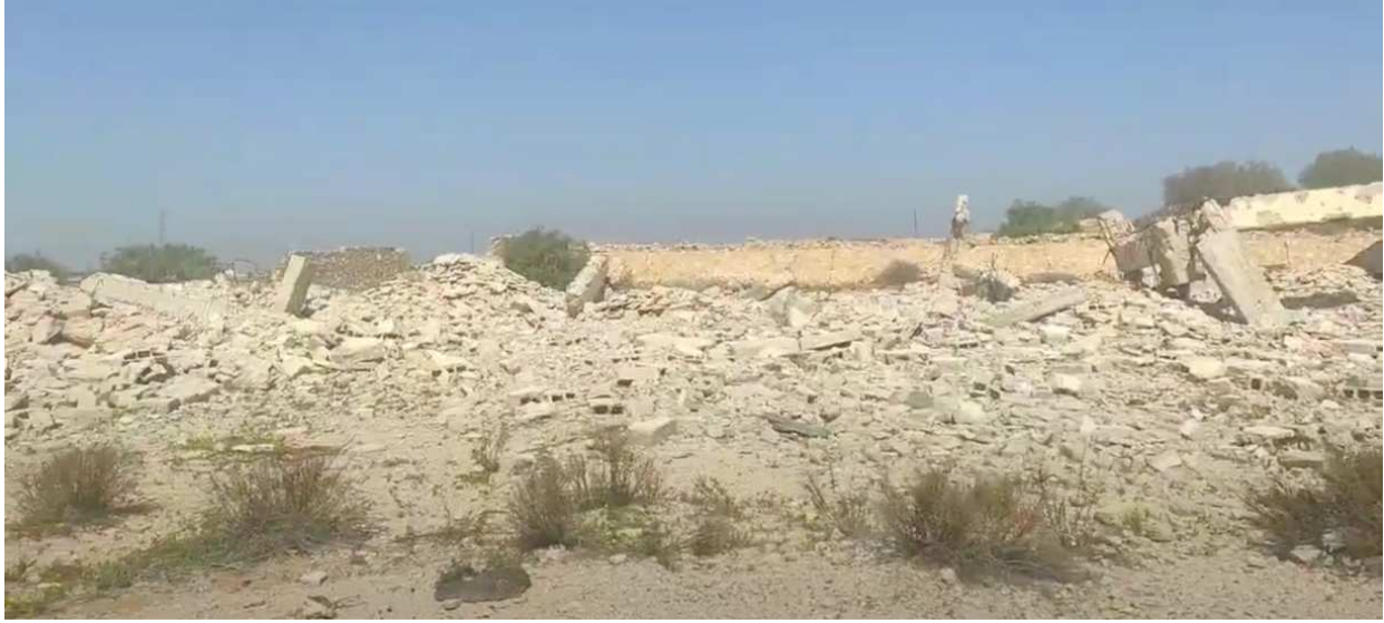
صورة 17: لقطة مئبته من فيديو تظهر بقايا المدرسة بعد القصف.
