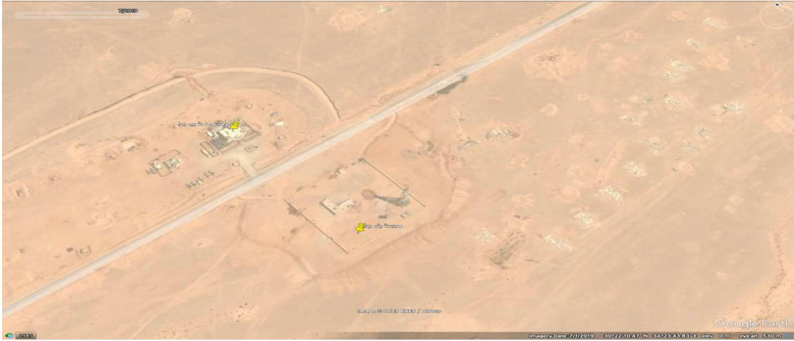
صورة 81: بتاريخ 7 يناير 2019 تظهر إنشاء برج اتصالات لاسلكية داخل المدرسة وامتداد التحصينات الرملية لتشمل محيط المدرسة بشكل كامل. المصدر: جوجل إيرث برو.
