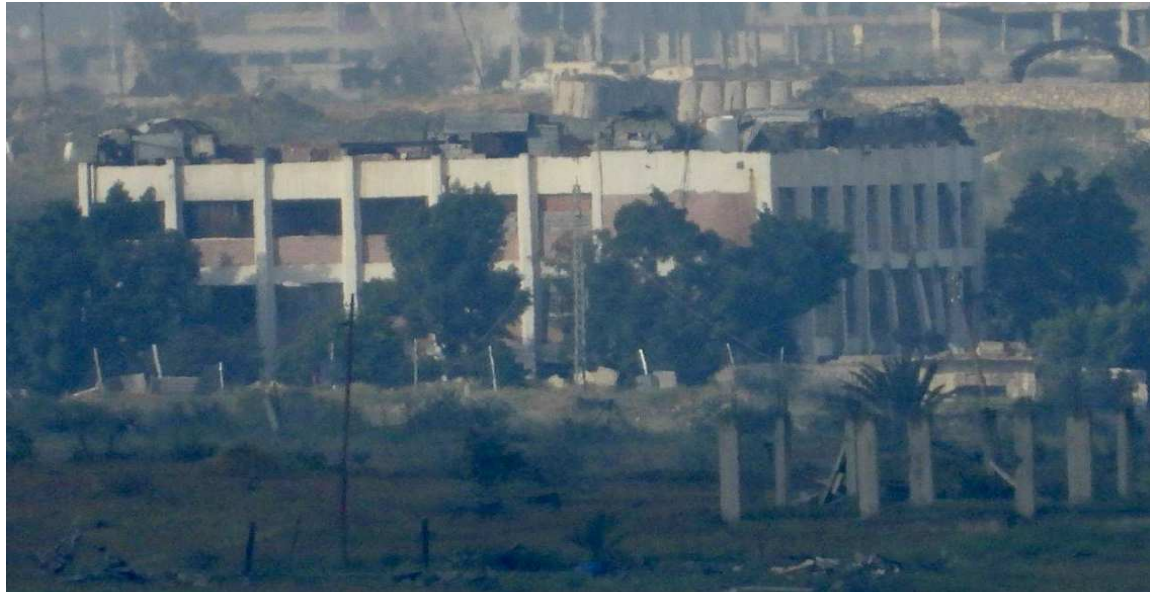
صورة 43: تظهر صورة حصرية حصلت عليها المؤسسة بتاريخ 15 مارس 2023 تحصينات عسكرية فوق سطح المدرسة وحولها
