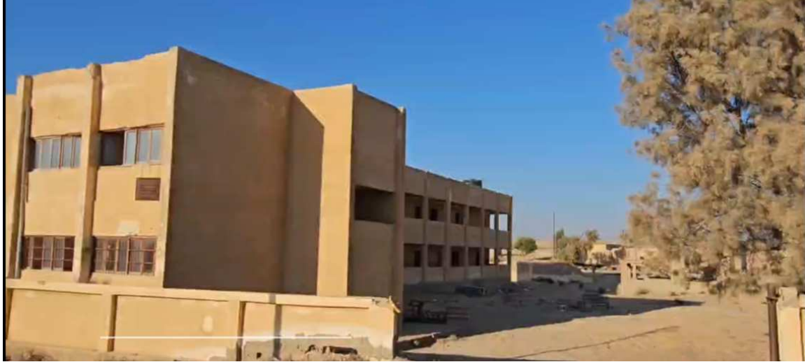
صورة 83: صورة مثبتة من فيديو حصري حصلت عليه المؤسسة في أبريل 2023، يوضح حالة المدرسة بعد إغلاقها لمدة خمس سنوات
